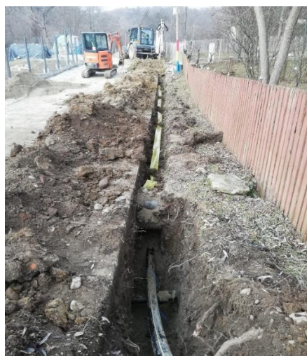
Racord la gaz și lucrări de extindere a rețelei de gaz în satul Provița de Jos (ian 2023)
