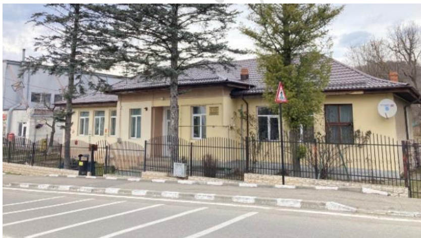
Clădirea în care funcționează școala din Provița de Jos (aripa stângă) și dispensarul local (aripa dreaptă)
