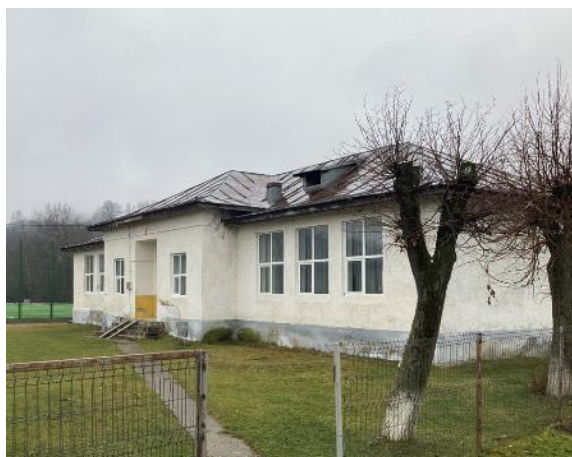
Clădirea în care a funcționat grădinița din Drăgăneasa
